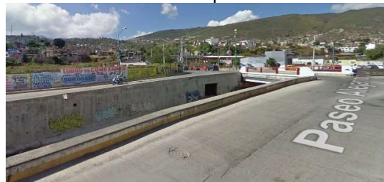
Cs2- Vista del ducto de descarga al Río Huacapa
