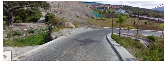
Cs6- Cauce y cruce de vialidad, en el ingreso a la zona urbana
