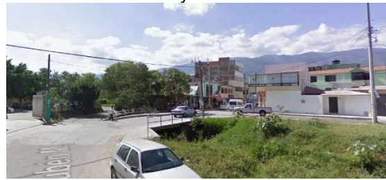
Cs5- Puente y cruce de cauce
