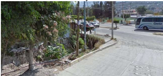
Cs1- Vista de cauce y cruce de vialidad
