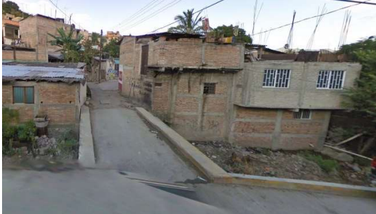
C5- Cauce y alcantarilla: el cauce es lateral a la vialidad
