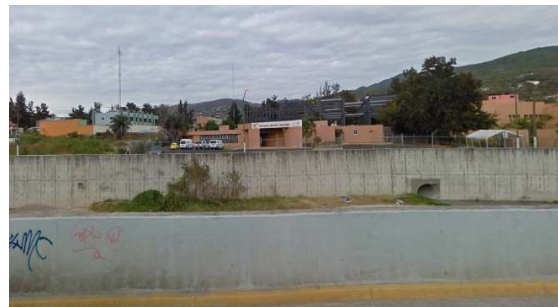
C3- Descarga en el Río Huacapa, se nota la sobreelevación de los muros que forman el cauce
