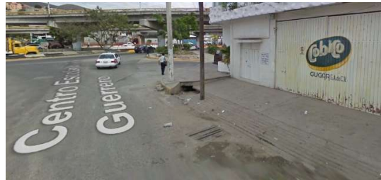
Cs10- Vista del ducto de salida del cauce
