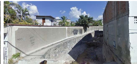
Cs2- Vista de cauce confinado por muros de edificaciones
