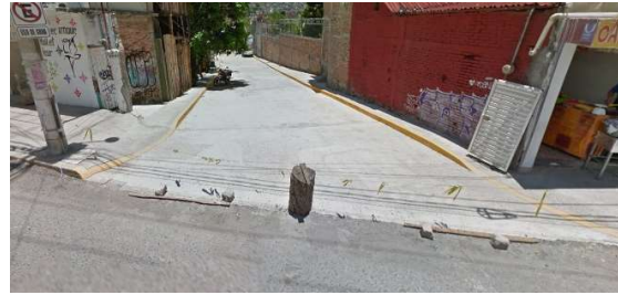
C3- Cauce confinado y desviado a un costado de la calle
