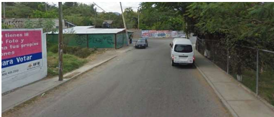
Cs10- Vista del cauce, no se aprecia la obra de cruce
