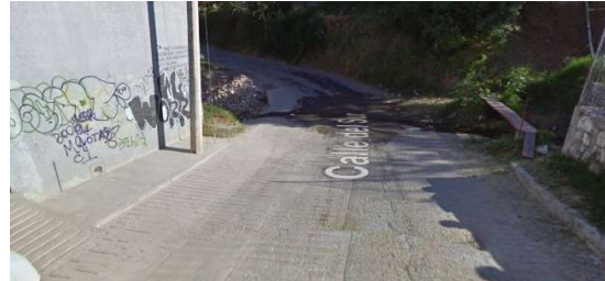
C6- Vista del cauce rectificado: sólo rectificó el último tramo
