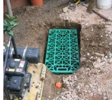
Ejemplo de Pozos y zanjas de infiltración
