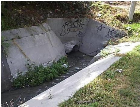
Alcantarilla que sirve de cruce con el Boulevard Vicente Guerrero por donde transitan los escurrimientos residuales. Barranca El Tomatal
