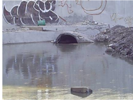
Captación de las aguas negras provenientes aguas arriba
