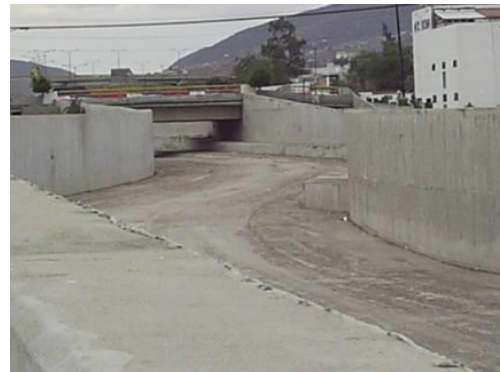
Trayectoria de tubería encofrada por el interior del cauce del río Huacapa
