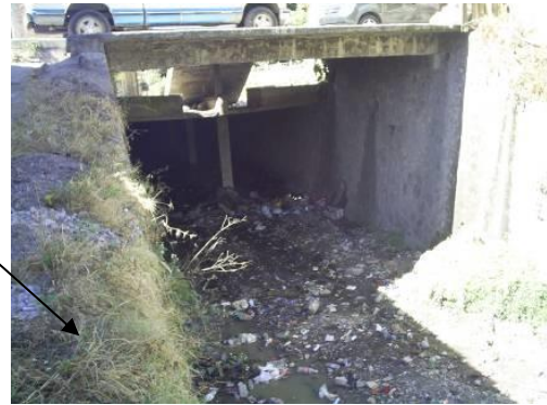
Sección de la barranca Apatzingo, inicio de tramo encofrado en la calle Procopio
